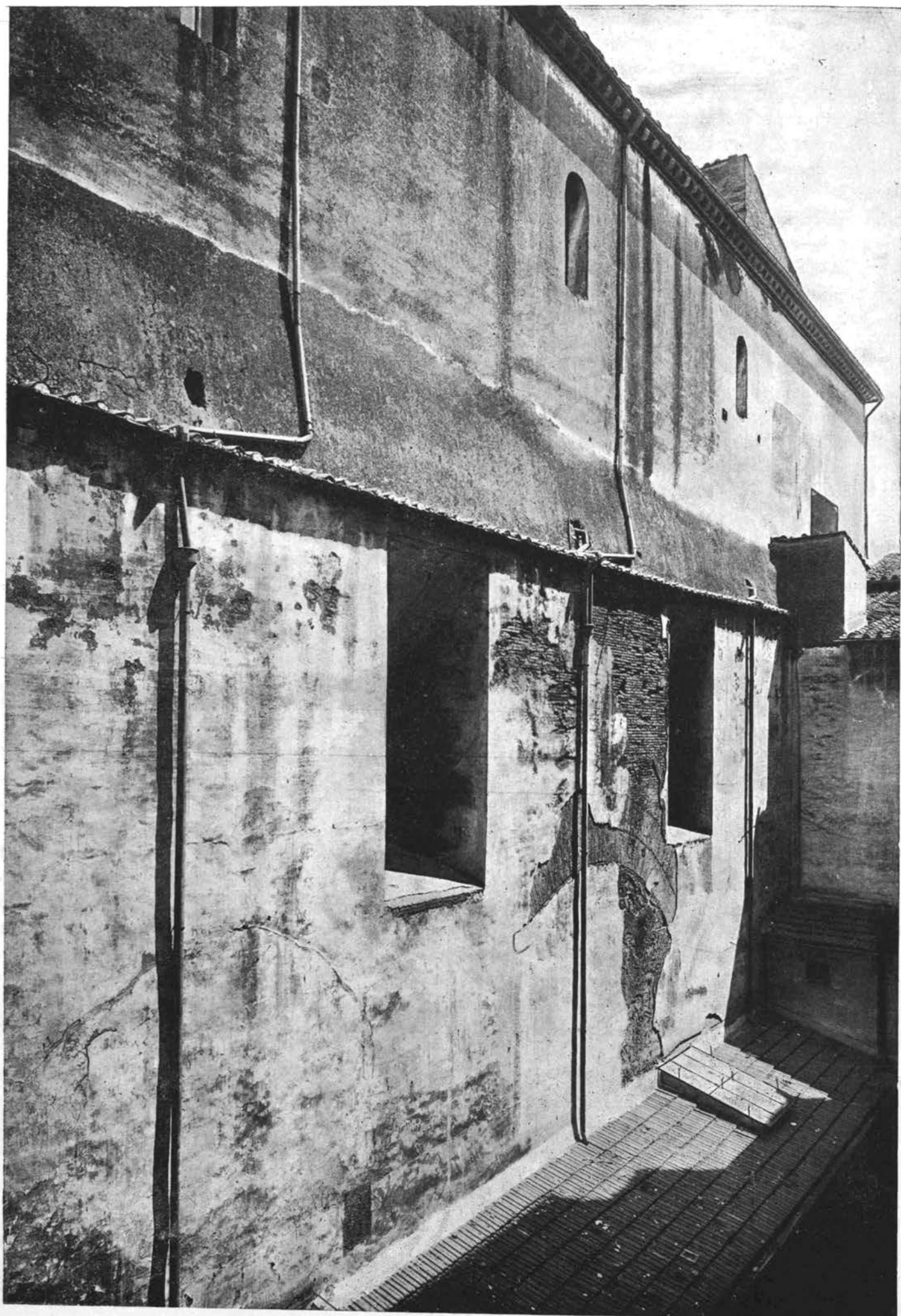
Fig. 103 — S. CROCE — Esterno da Ovest — Muro C D.
